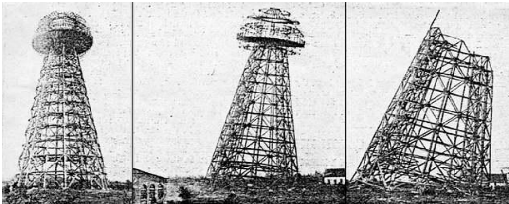
Phases de démolition de la tour Wardencllyffe
